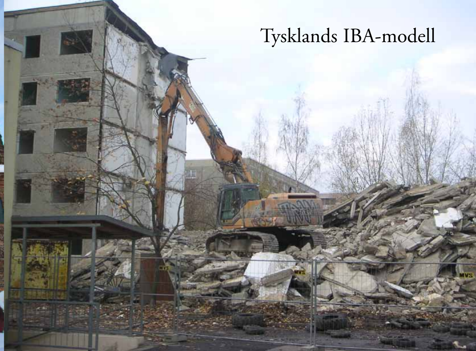
Rivning har varit en del av omvandlingen i Halle Neustadt.
